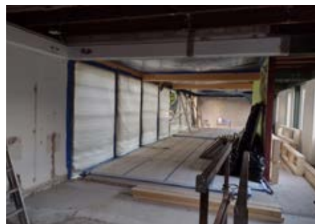
Gruppenräume Vorbereitung neue Fenster
