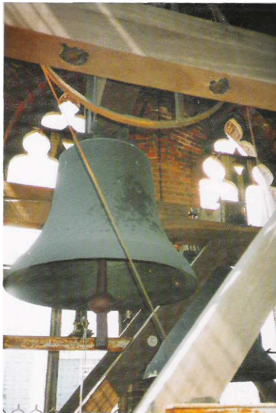
Blick in den Glockenstuhl
