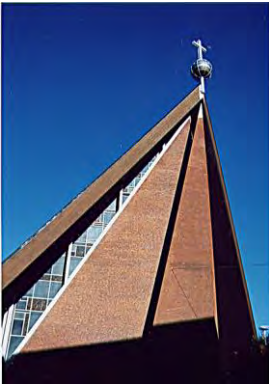
St. Michaelis Doventorsteinweg 51
