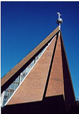
St. Michaelis Doventorsteinweg 51
