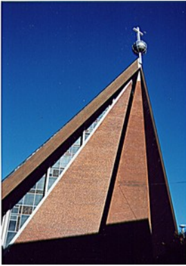
St. Michaelis Doventorsteinweg 51
