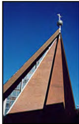
St. Michaelis Doventorsteinweg 51
