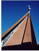
St. Michaelis - Kirche Doventorsteinweg 51
