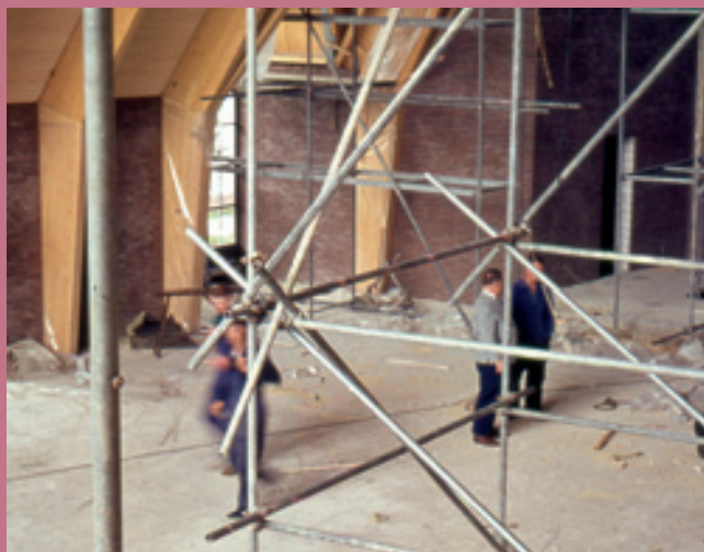
Blick in den Kirchraum während der Bauphase
