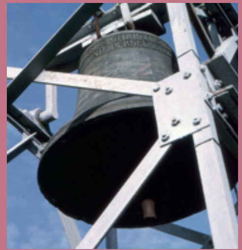
Provisorischer Glockenturm während des Neubaus
