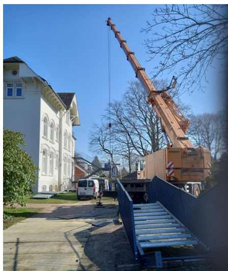
Hier beginnt der Aufbau der neuen Treppe an der Villa.
