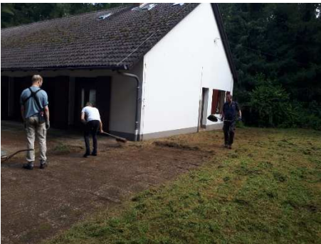
Freilegen der Platten
